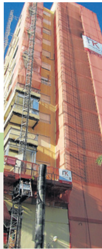
Una rehabilitación de Renovak.
