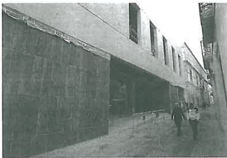
Fachada del edificio del Hospital Provincial que por el momento no ha sido inaugurado.
