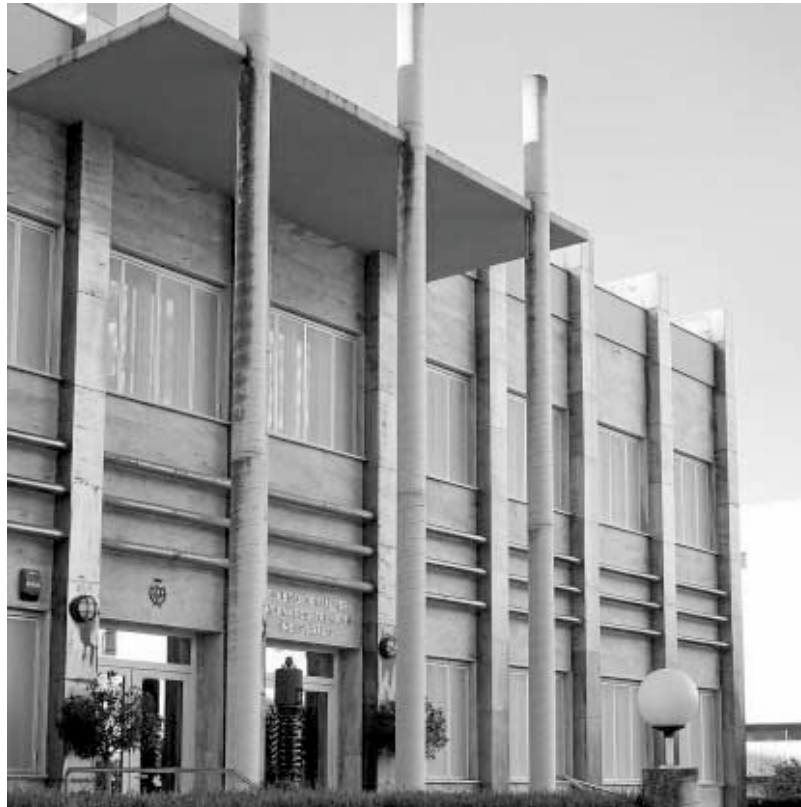
Sede del Colegio Oficial de Ingenieros Técnicos Industriales de Huelva.
