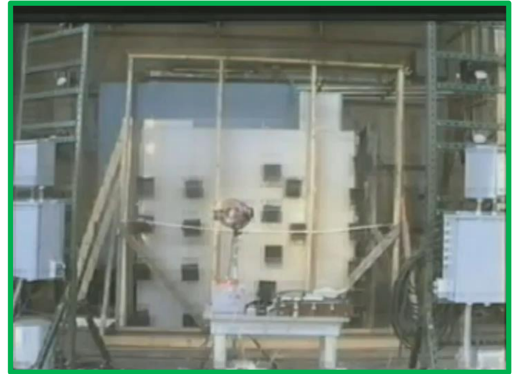
Arco confinado en una celda de Media Tensión
